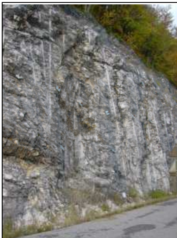
Protection contre les chutes de pierres le long de la RD 110
