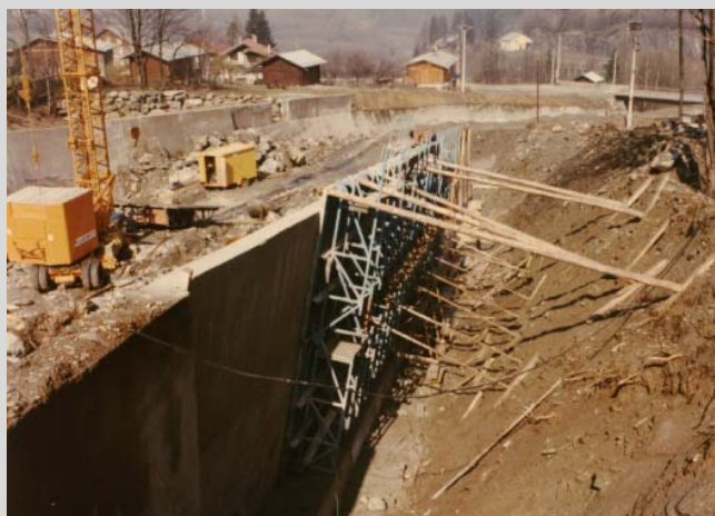
Endiguement du bief inférieur – avril 1977
