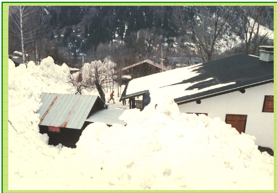
Taconnaz le 20 mars 1988 Le front de l'avalanche (cliché RTM)
