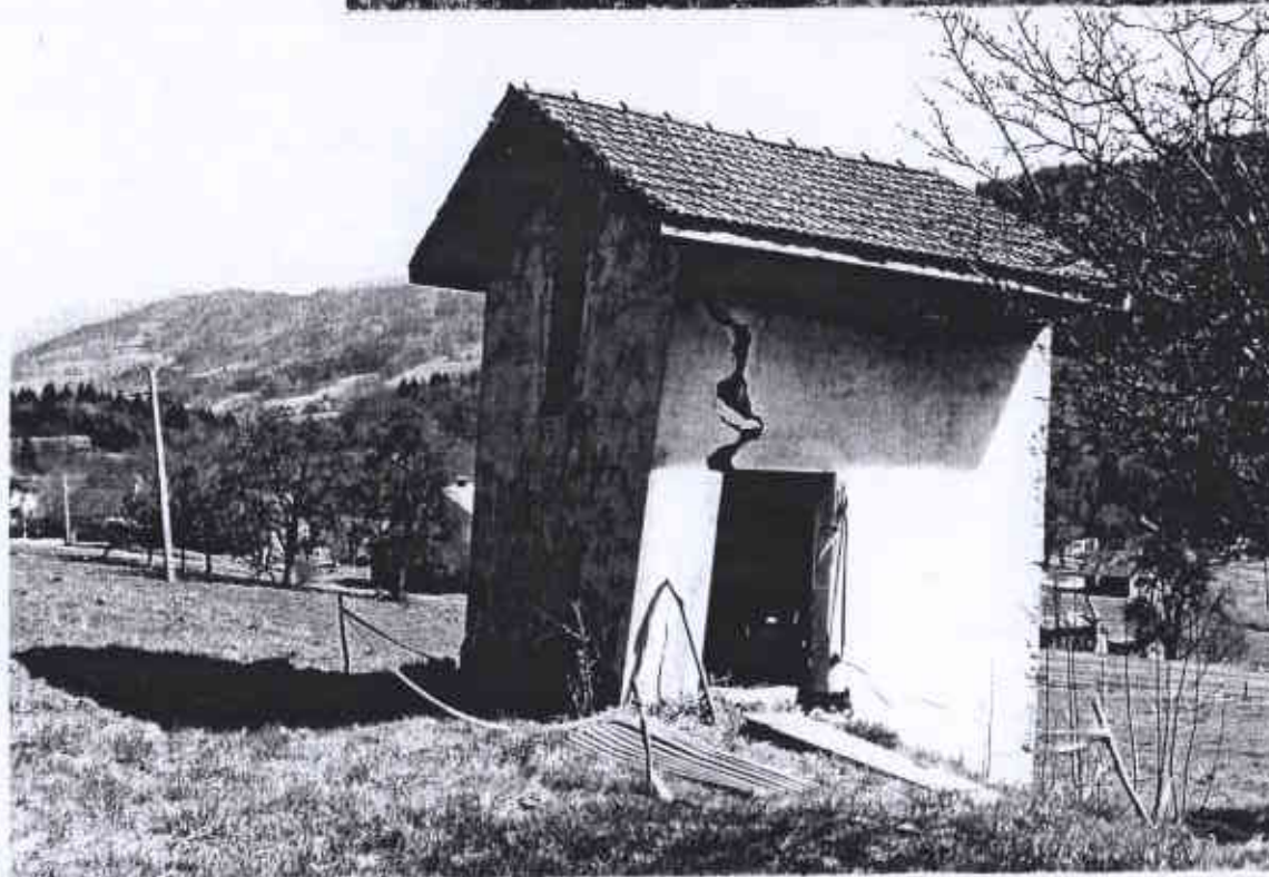
Remise qui a dut être démolie
