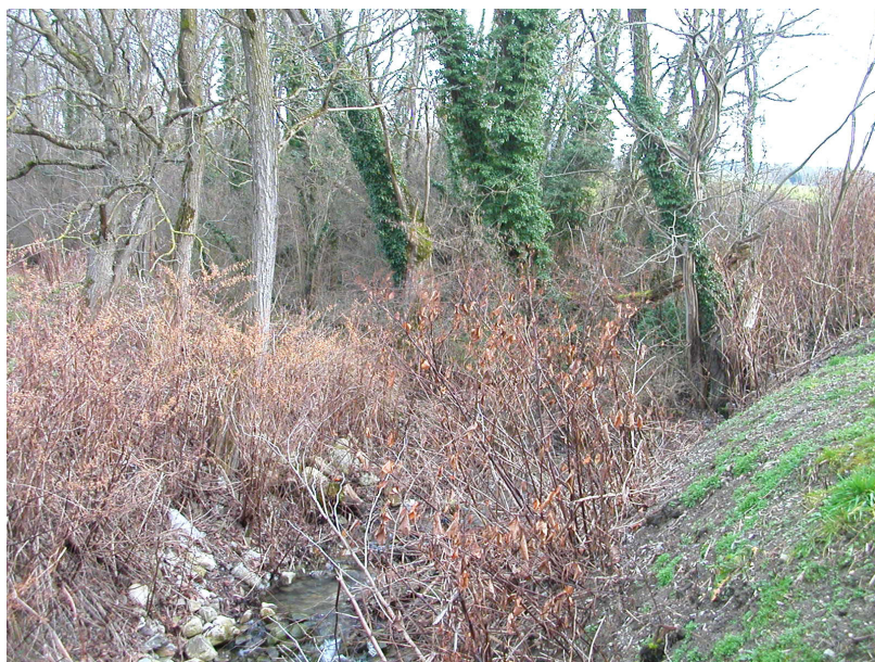
Marcellaz-ET1 : Ruisseau des Samsons – Thalweg localement déstabilisé notamment en rive gauche.
