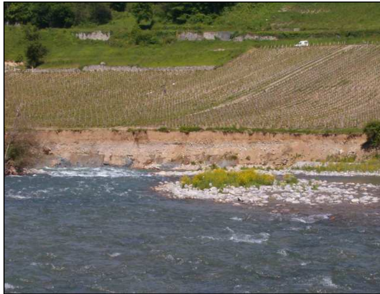
Photo 1 : Affouillement des berges aux VIGNES DU PONT
