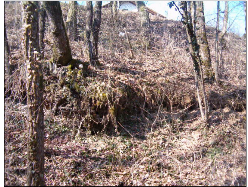
Photo 6 : niche d'arrachement présente le long du versant
