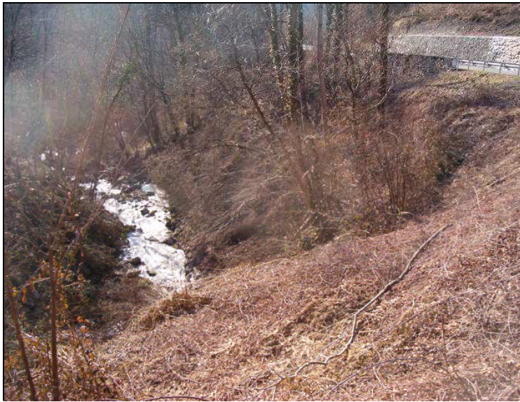
Photo 2 : L'encassement du MARAVANT au niveau du croisement avec la RD21
