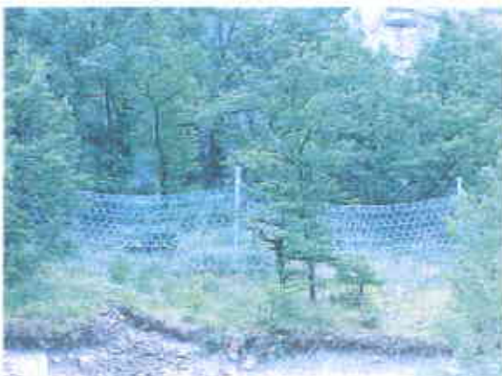
Mesures prises par la commune : Mise en place de filets de protection et d'un merlon.
