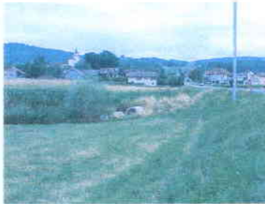
Canalisation permettant le passage de l'eau en cas de fortes pluies sous le Pont de la fruitière.
