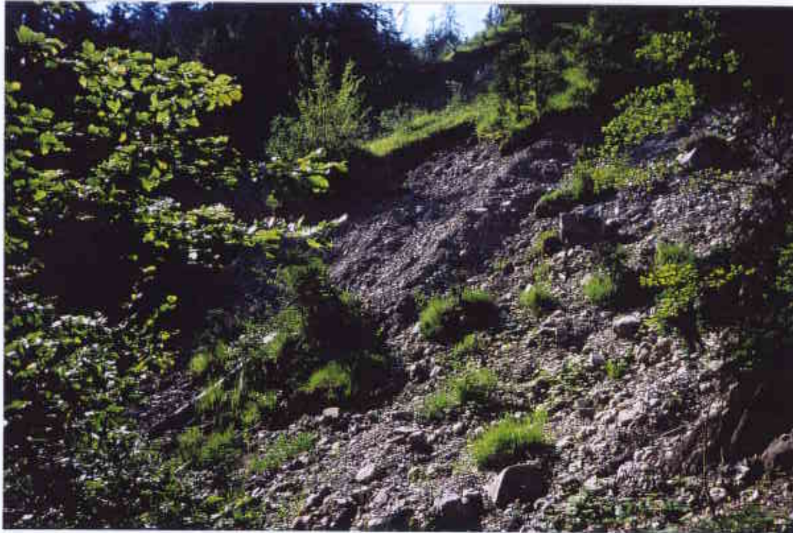
Photo 2 : Zone d'affouillemnt et de ravinement le long du ruisseau de Fillian.
