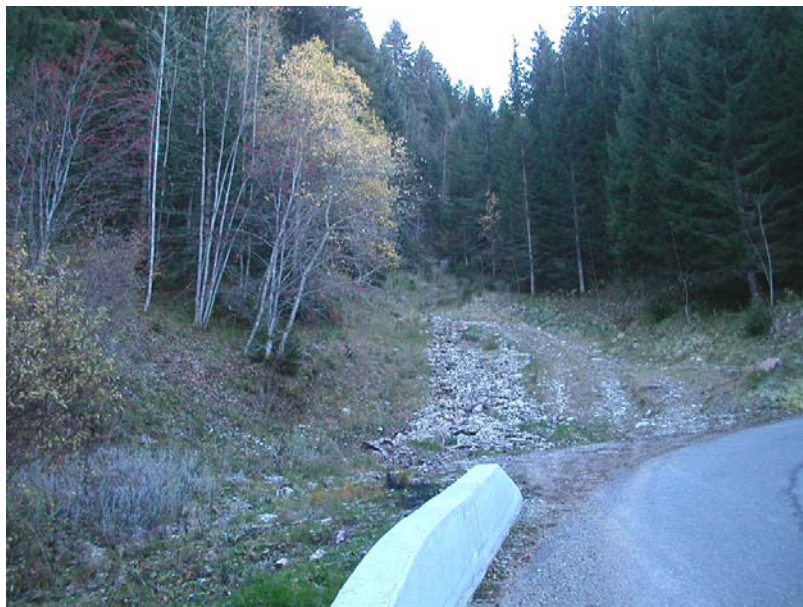
Nancy-ET1 : RD119, virage entre la Pliore et les Chavannes – Petit ruisseau pouvant occasionner des débordements sur la chaussée.
