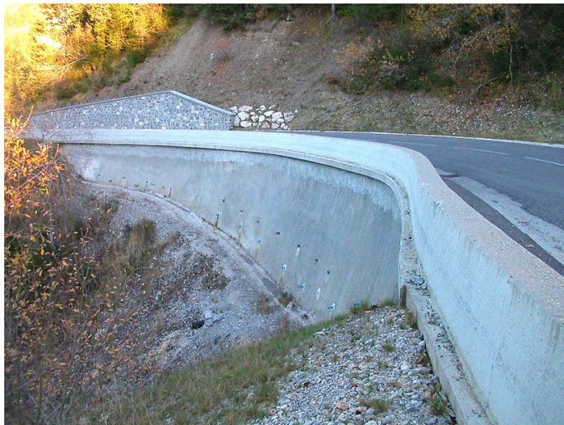
Nancy-OG3 : RD119, en aval du point coté 1318 – Murs de maçonnerie cyclopéenne, enrochements et soutènement de chaussée.
