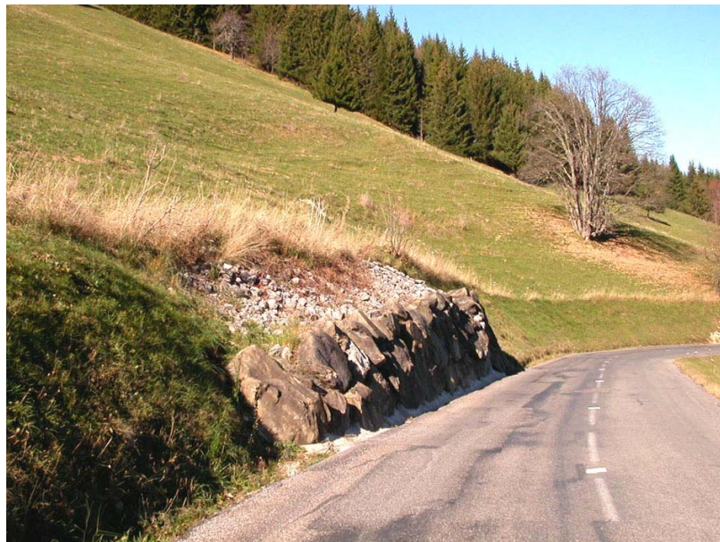
Nancy-OG1 : RD119, entre Romme et les Chavannes – Confortement localisé du talus par enrochements.
