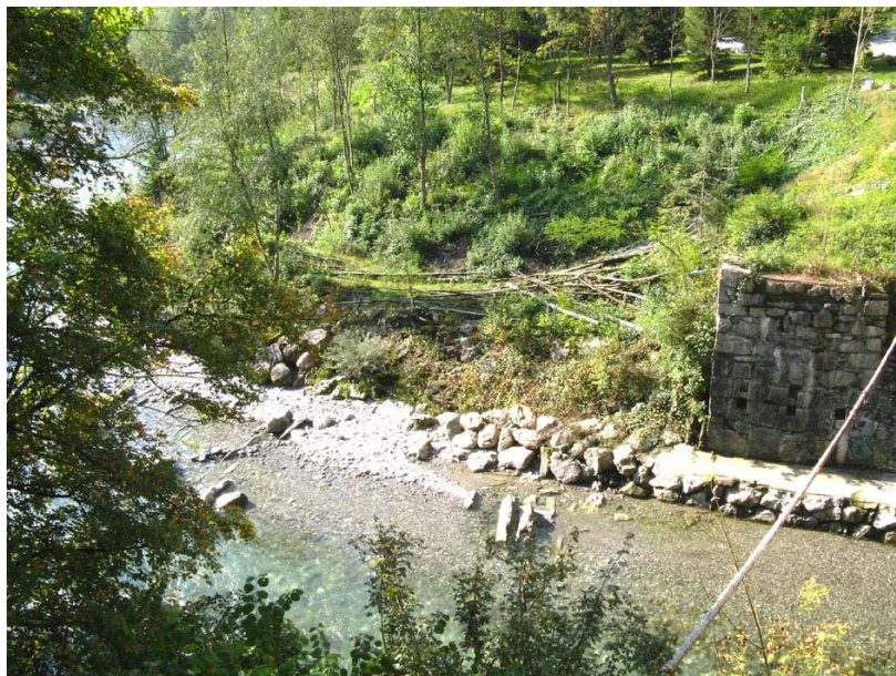
Naves-OGT1 : Rivière du Fier, au niveau du pont de la RD5 – Protection localisée de berges par des enrochements.
