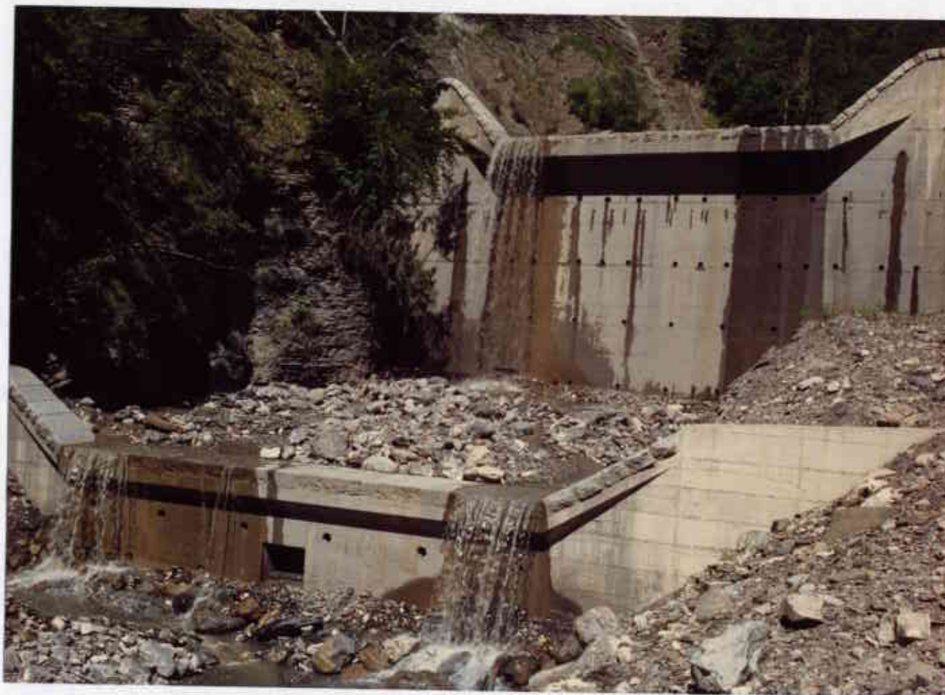
SAMOENS - Travaux de correction torrentielle hydraulique dans le bassin du Clévieux - Grand barrage de sédimentation ( H = 11 m) construit en 1974 et son contre-barrage.
