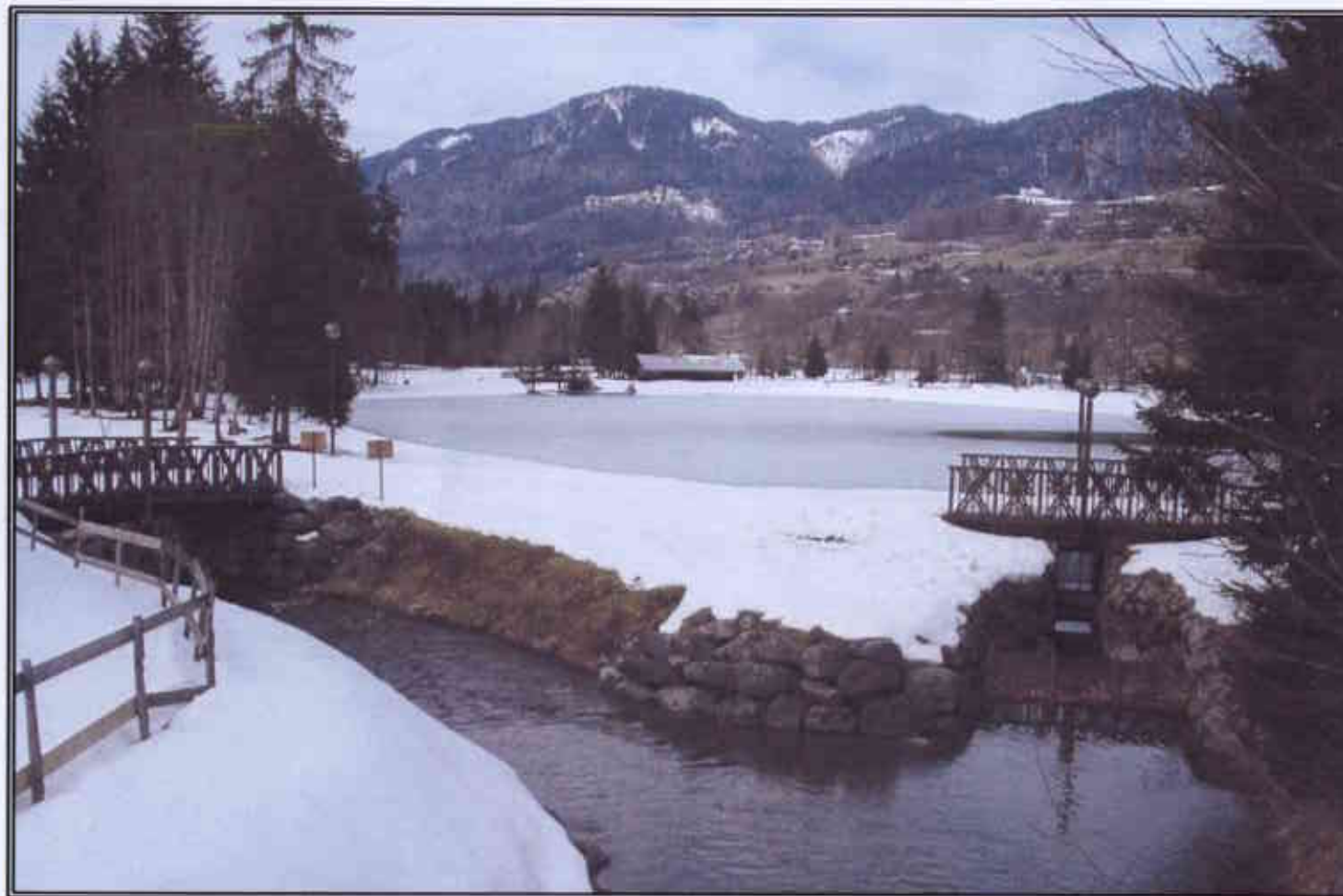
Photo n° 2 : Prise d'eau du Lac aux Dames (Cliché RTM - Février 2003 )
