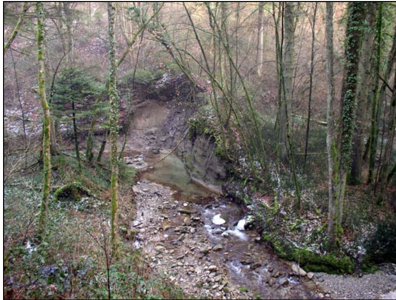
Figure 15- Erosion de berges du ruisseau le Genon
