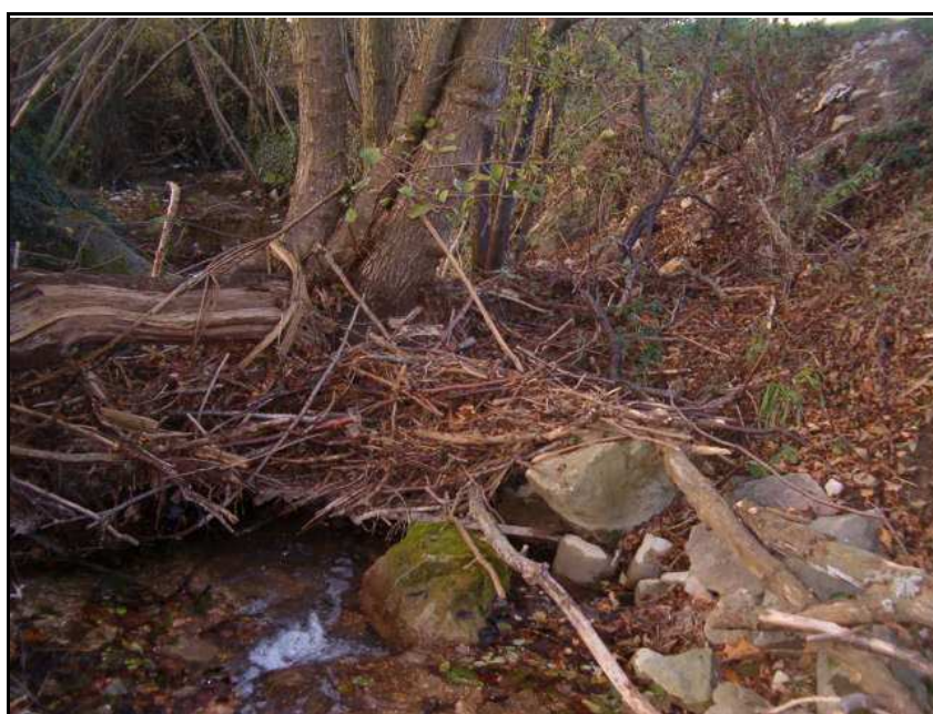
Formation d'un embâcle par des branches d'arbres.
