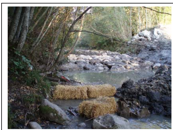
PRA-03 : Seuil en construction dans le lit de l'Arly au niveau de Chenux.
