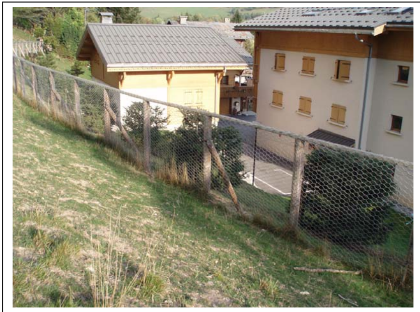
Photo n°6 : Barrière de protection contre les chutes de blocs de Glace, copropriété Praz de Megève Source MB Management, Octobre 2009
