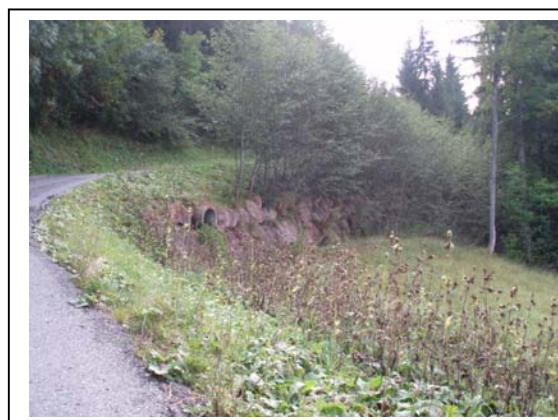
PRA-09 : Soutènement de la route de « Sur le Crêt » en enrochement
