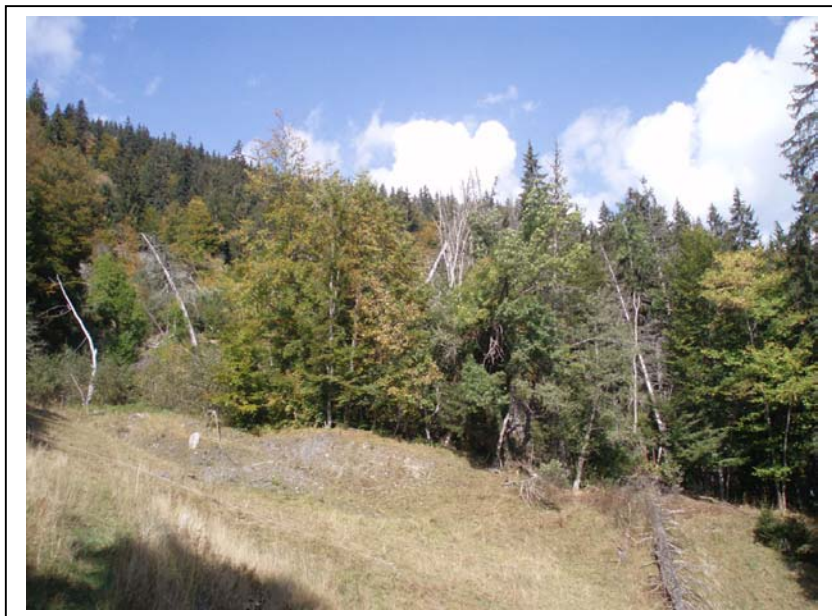
Photo n°9 : Glissement du Bois des Têtes. Terrain chahuté, arbres tombés ou déstabilisés.
