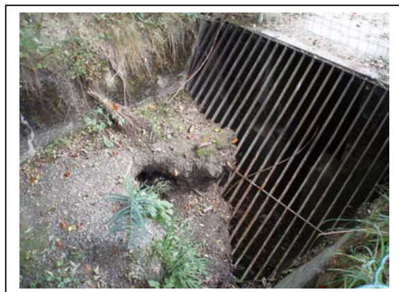
PRA-02 : Grille de protection devant l'entrée de la buse dans le village vacances au lieu dit Meuret
