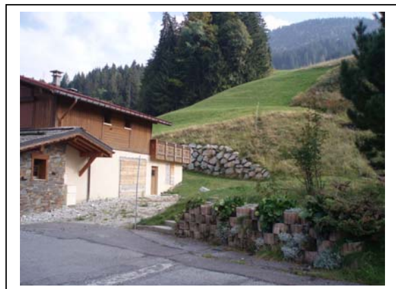
PRA-08 : Mur de soutènement d'un talus en enrochement au lieu dit « les Bernards »
