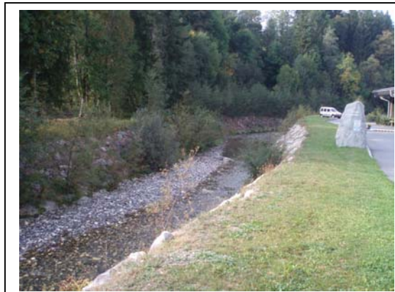
PRA-06 : Enrochement des berges de l'Arly en rive droite et gauche au niveau de la station d'épuration
