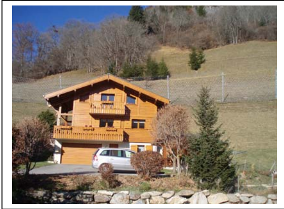
PRA-11 : Ecran pare blocs, doublé par du grillage au lieu dit « Les Raies »
