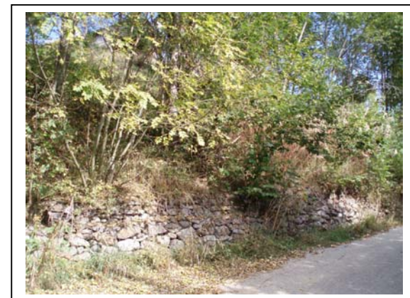
PRA-10 : Gabion sur le chemin d'accès à l'Orçon
