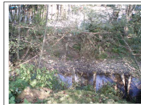
PRA-04 : Pieux pour la stabilisation des berges de l'Arly au niveau de Chenux
