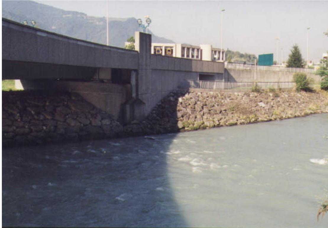
**Photo 8 : Protections de berges en enrochements sous le Pont de l'Europe (Cliché RTM –Septembre 2000)**
