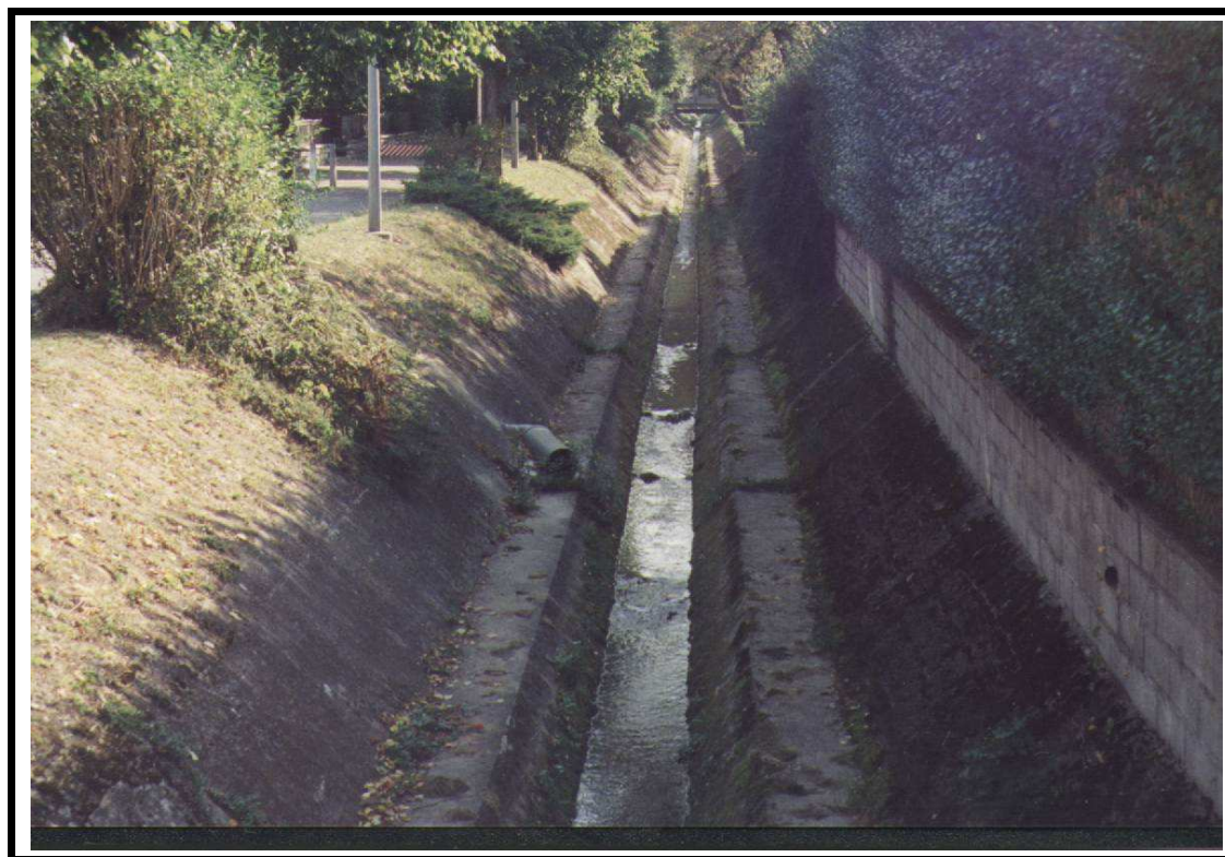
- Ruisseau de l'Englennaz dans sa traversée de Cluses-
