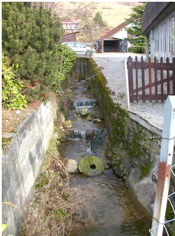
Contamine-OTG3 : Rau de la Courbatière – Canalisation et succession de seuils en amont de la RD1205.
