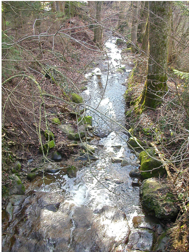
Contamine-OTG2 : Ruisseau des Samsons – Lit en enrochements cimentés sous le pont.
