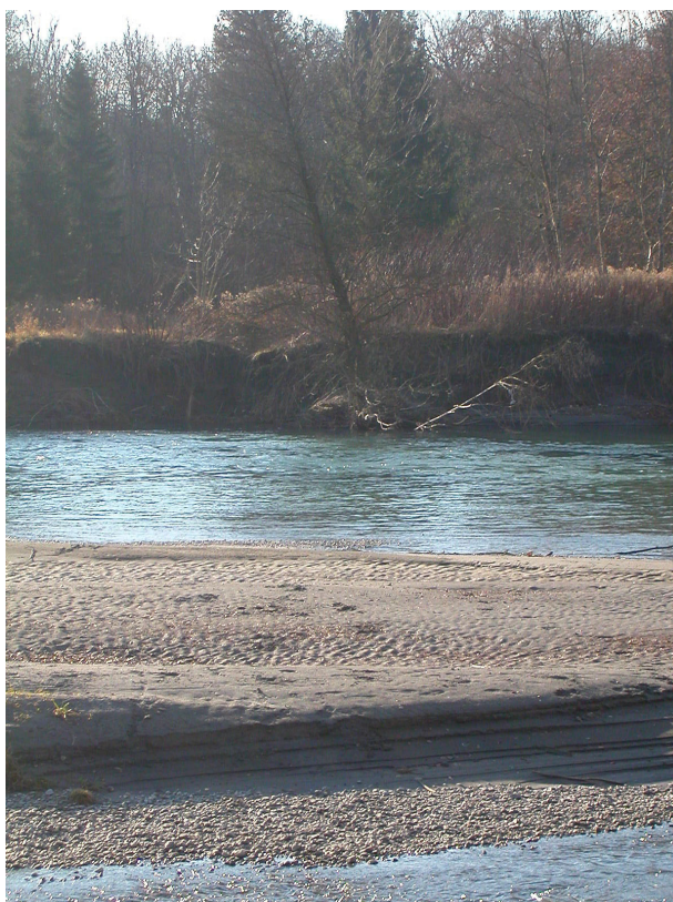
Contamine-ET1 : L'Arve – Effondrements localisés de berges et exhaussement / engrèvement du lit.
