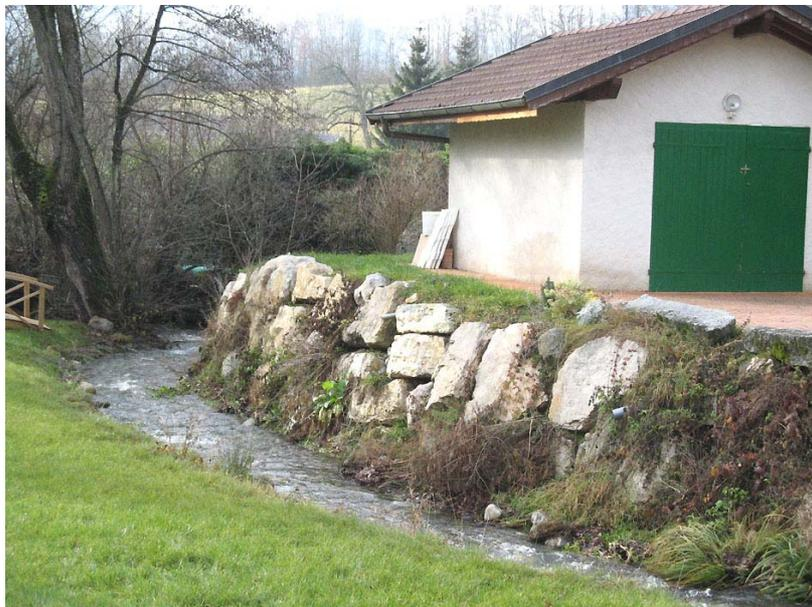
Minzier-OT1 : Ruisseau du Flon, aux Baraques – Enrochements en rive droite pour conforter les berges au niveau d'une habitation.
