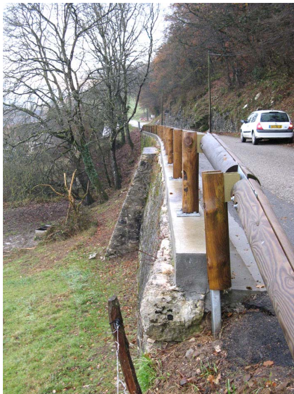
Crempigny-OG1 : RD31, au dessus de Belle Fontaine – Confortement aval renforcé par un pilier-contrefort.
