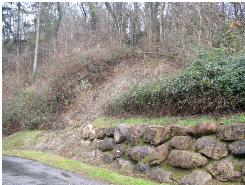
Crempigny-OG2 : RD351, Sous Bramafan – Confortement de la base des talus déstabilisés par des enrochements.
