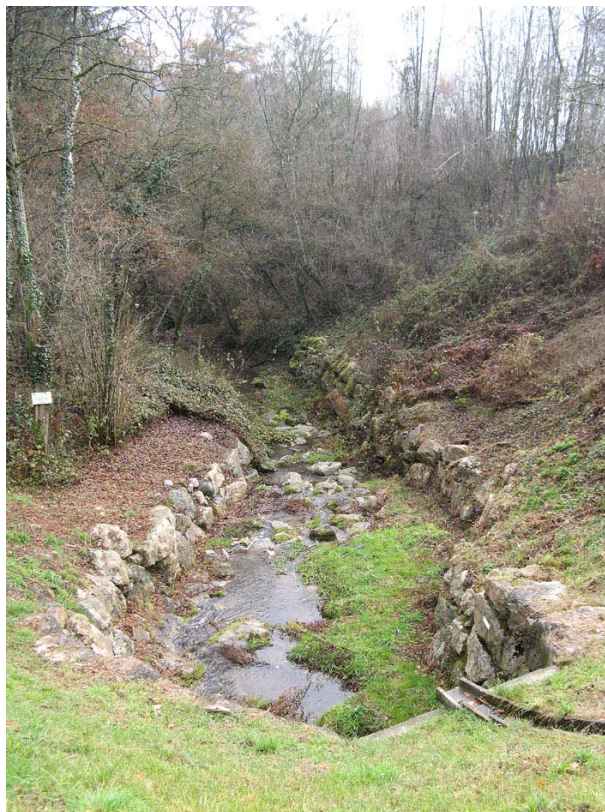
Crempigny-OT1 : Ruisseau des Esserts, en aval de la RD351 – Enrochements de berges.
