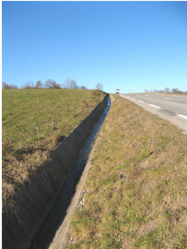
Menthonnex-OT1 : RD910, entre Doucy et Pavully – Fossés de recueil des eaux de ruissellement.
