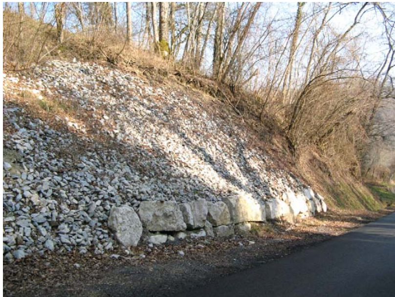
Menthonnex-OG1 : RD5, au Marteret en rive droite de la Morge, alt. 445m – Confortement de talus par enrochements.
