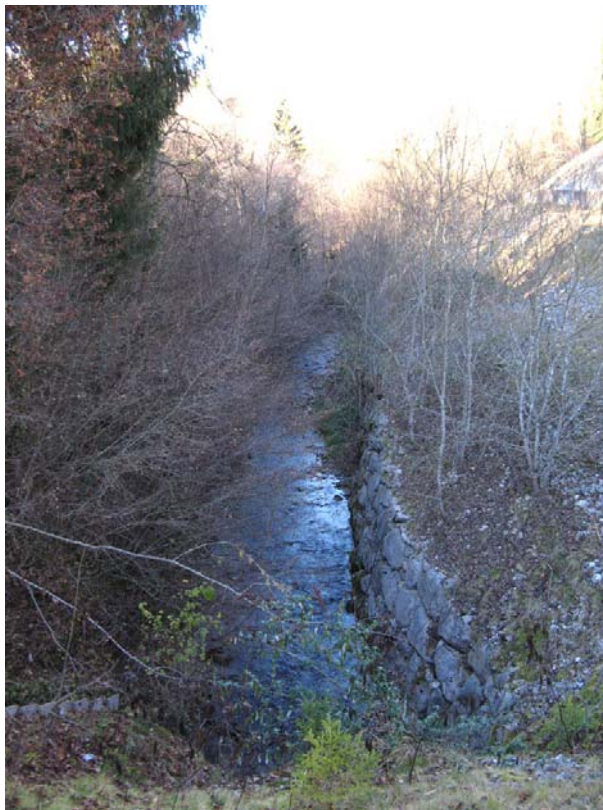
Menthonnex-OGT1 : Rivière de la Morge, en amont de la RD5 – Enrochement de berges.
