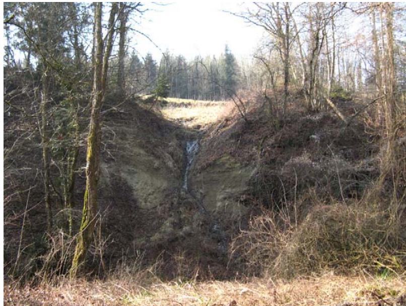
Menthonnex-EG1 : Rivière de la Morge, en aval de la RD5, en bordure de la route rejoignant Thusy – Glissement en rive droite.
