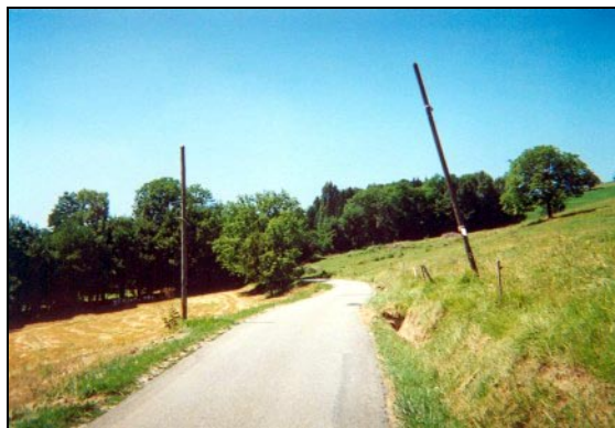
Figure 18 - Fluage le long de la route menant à Chez Levet, Epagny
