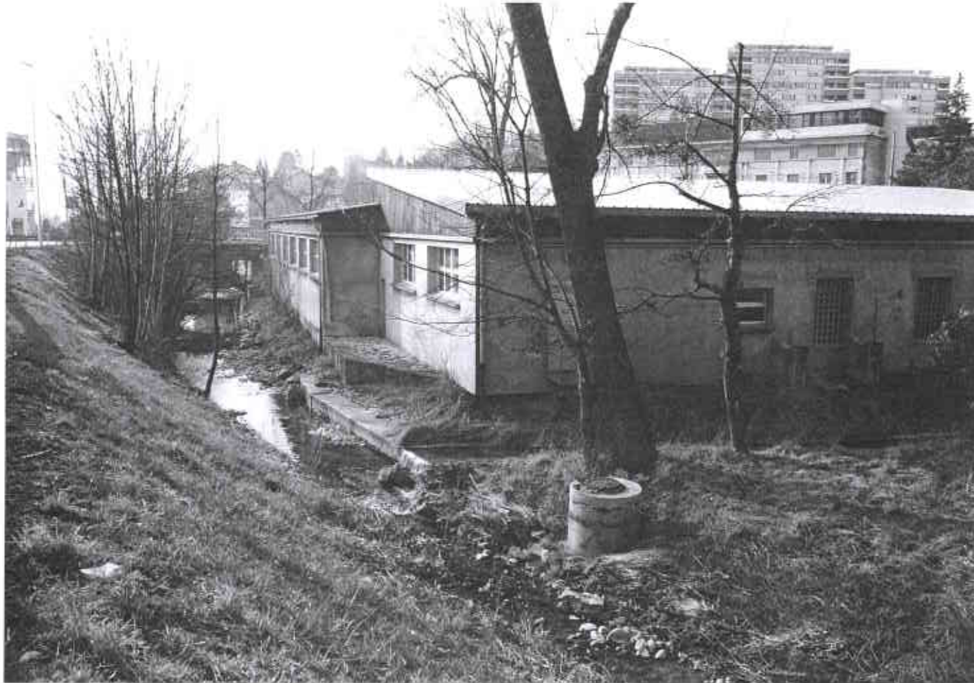
Commune de SAINT-JULIEN Confluence du ruisseau de l'Arande ( droite de la photo) et du ruisseau de Ternier, au niveau des bâtiments de la Poste. Cliché R.T.M. III/96.
