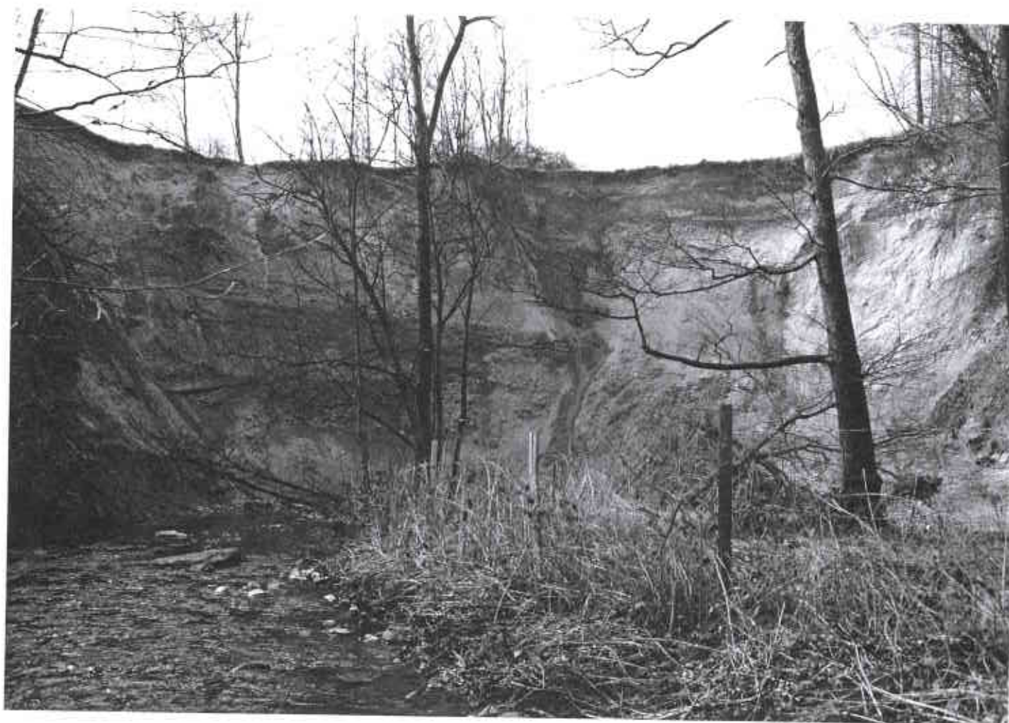
Commune de SAINT-JULIEN Important glissement de terrain en rive gauche du Nant de la Folle, dans le secteur de la Jarjeattaz. Cliché R.T.M. III/96.
