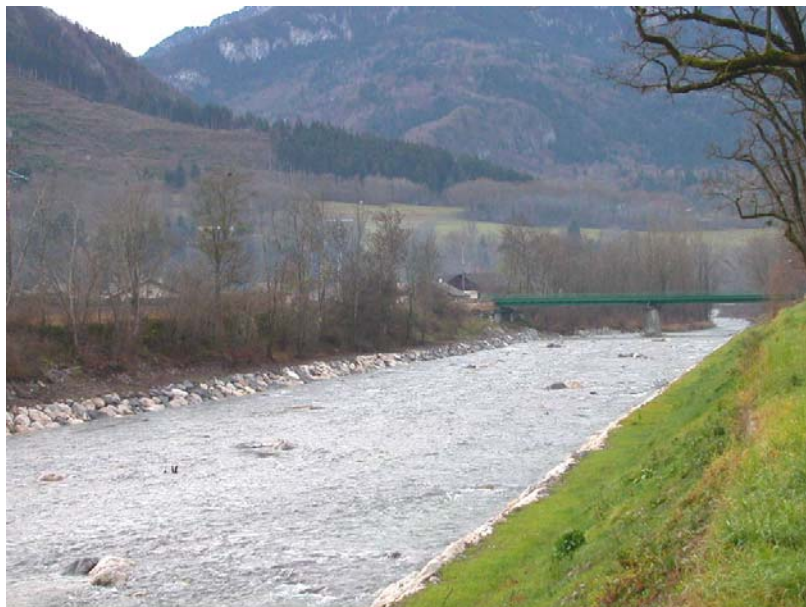
StPierre-ET1 : Torrent du Borne au niveau du Château d'eau – Endiguement du torrent dès la sortie des gorges.
