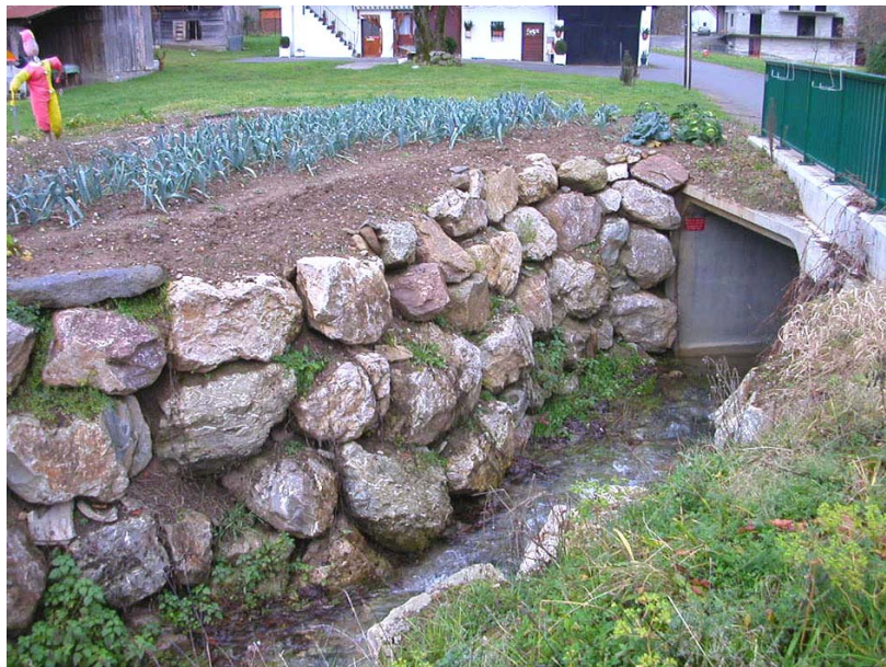
StPierre-OT3 : Torrent de la Bourre à la Sertaz – Confortement de berges par enrochements au niveau du pont.
