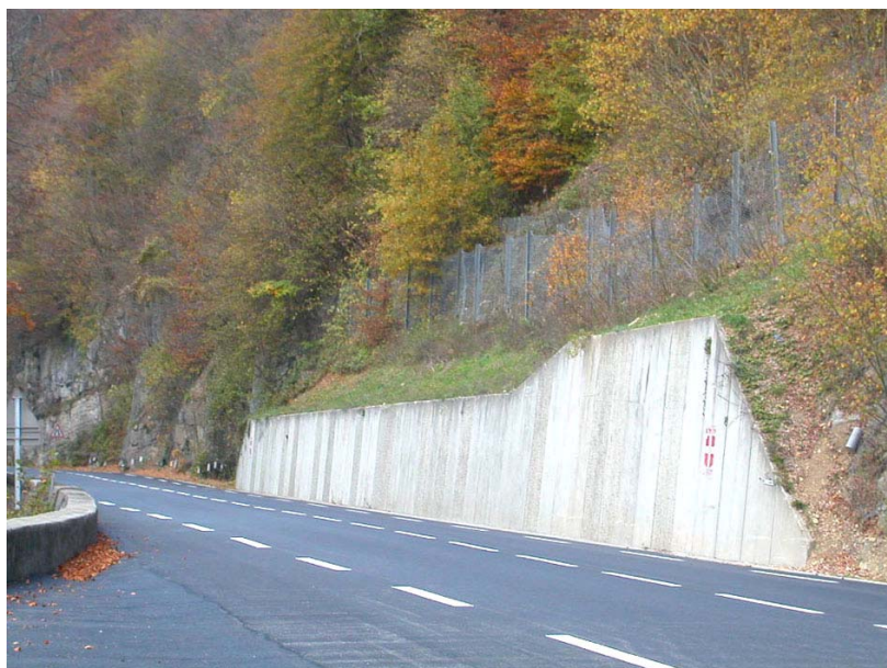
StPierre-OP3 : RD12, en limite de commune – Filets pareblocs en deux rangées parallèles et mur de soutènement de talus en dalles de béton.
