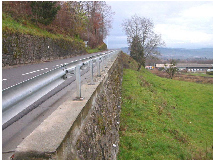
StPierre-OG1 : RD27, en dessous des Crêts – Confortement aval de la route par des murs empierrés drainés.
