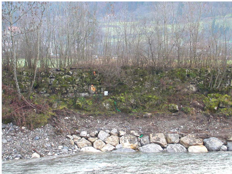
StPierre-OT1 : Le Borne au niveau du Château d'eau – Anciennes digues (murs de pierres) et renforcement localisé par enrochements.
