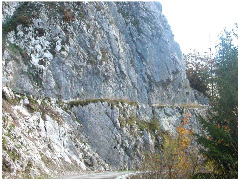
StPierre-OP2 : RD12, en limite de commune – Création d'une vire en pied de la paroi fragilisée et pose de filets grillagés.
